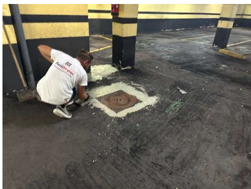
3. Reparação e remendos
