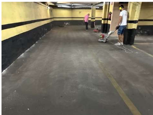
1. Lixagem e limpeza da superfície
